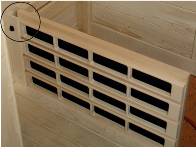
Abb. 33: Einsetzen der IR-Wärmeplatte VitaMy 164
