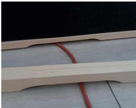
Abb. 34: Einsetzen der Aussteifungsleiste für IR-Wärmeplatten VitaMy
