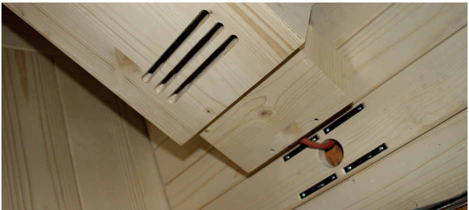
Abb. 28: Frontstrahler fixieren
