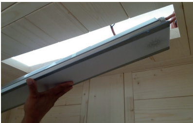
Abb. 45: Montage Farblampe
