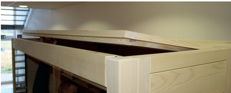
Abb. 18: Einlegen Dachelemente vorne
