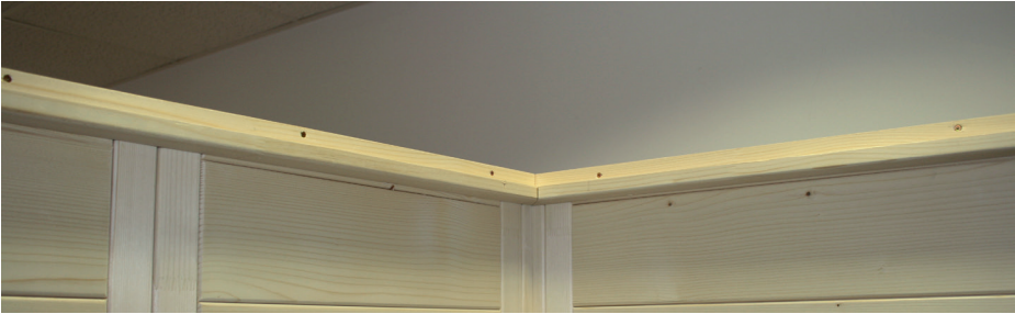
Abb. 17: Einlegen Dachelement hinten mit Lüfterausschnitt
